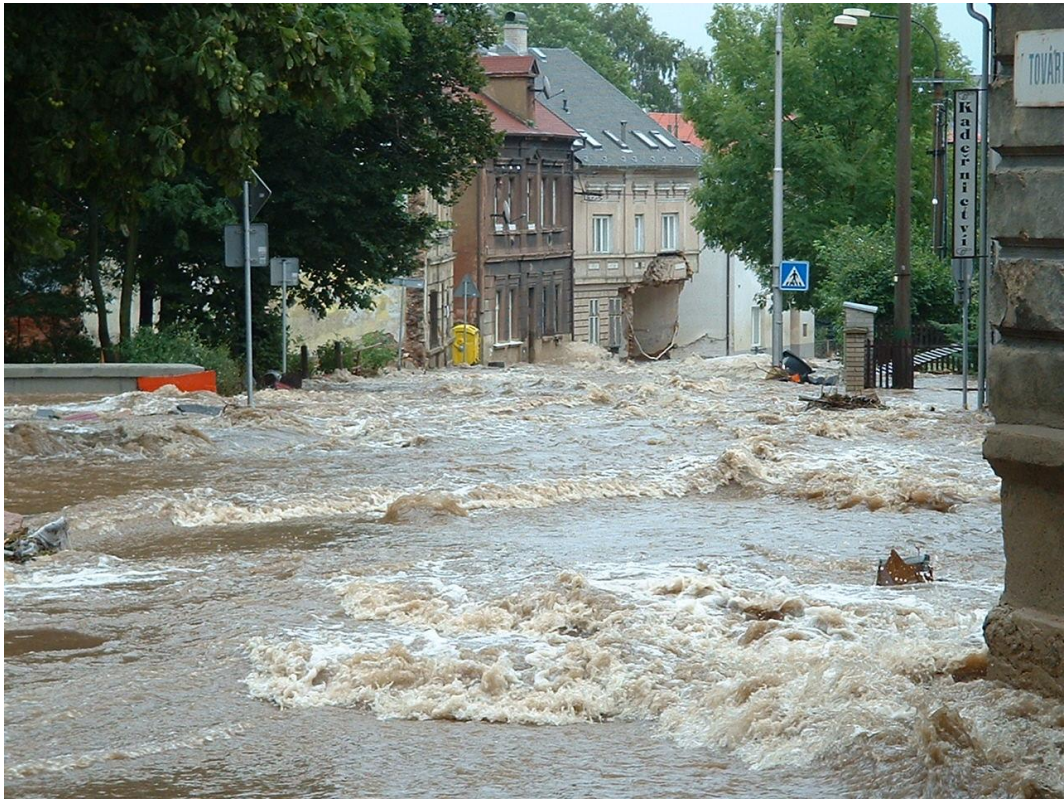
Podemletý dům musel být následně stržen.
