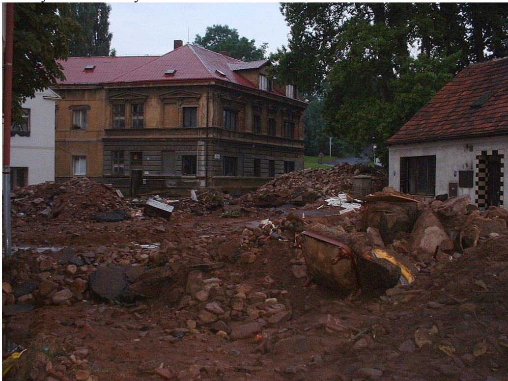
Pohled na stejnou křižovatku po povodni, tentokrát z Dlouhé ulice.
