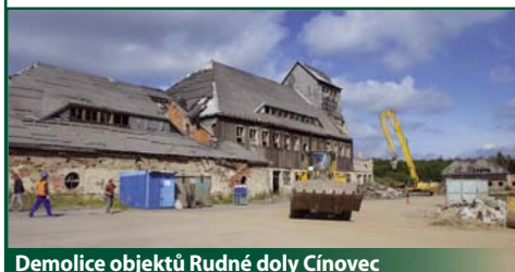
Demolice objektů Rudné doly Cínovec
